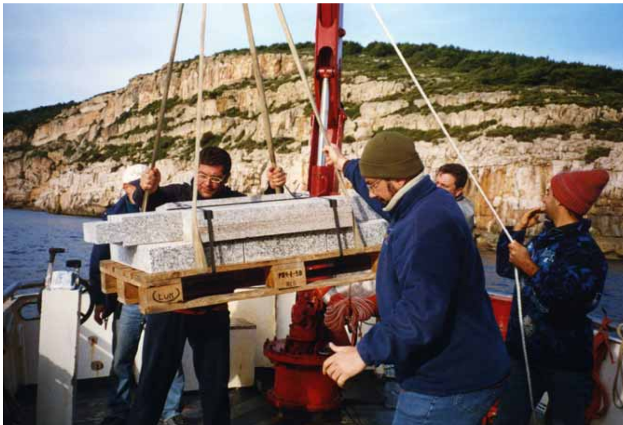
Fasi di affondamento del primo modulo nel sito individuato:
